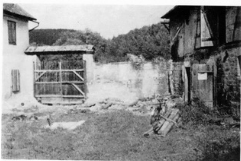
Eingang zur Schimmersburg vor dem Umbau
