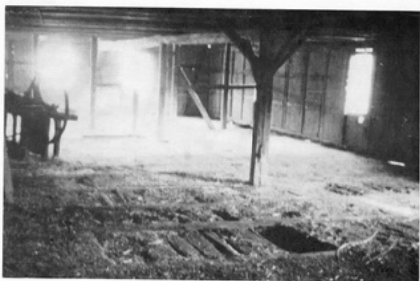
Scheunenboden vor dem Umbau zu Schlafräumen
